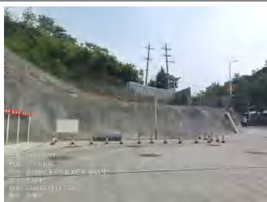
储罐区 4m 高的通气管
