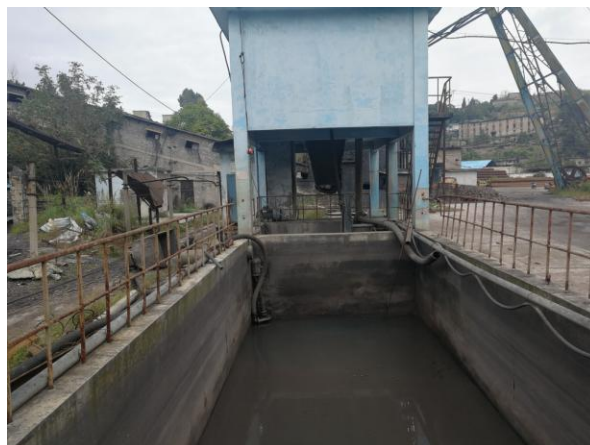
原有矿井水污水池
