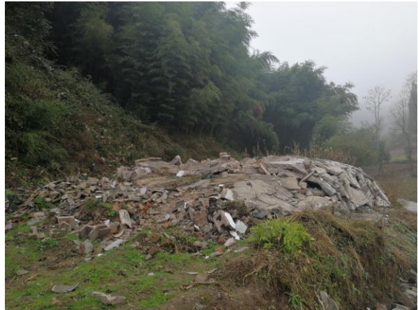
严家麻窝搬迁拆除
