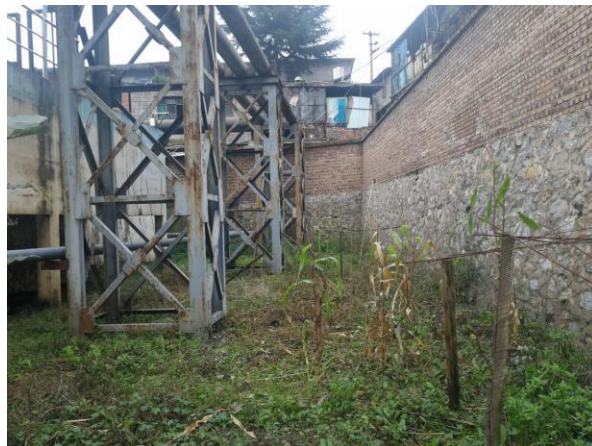
污水处理站挡墙及绿化
