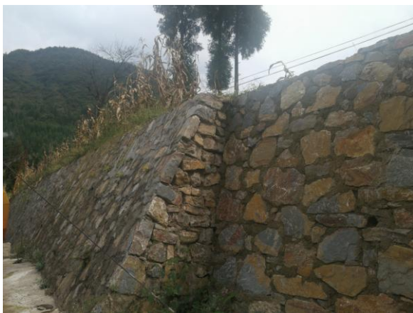
风井场地挡墙
