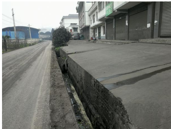
搬迁安置点道路及污水收集
