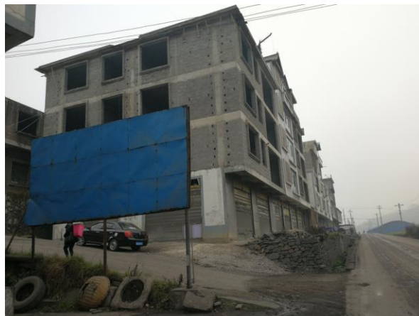
搬迁安置房屋建设
