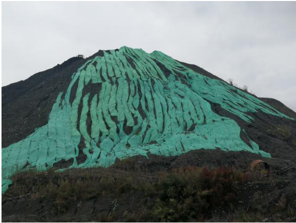
矸石场遮挡覆盖
