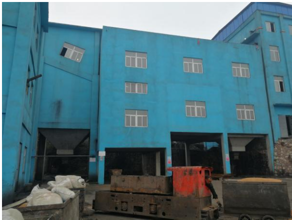
主井矸石仓及运输隧道
