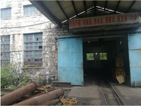
机修车间封闭厂房
