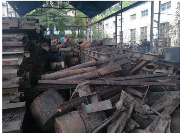
施工废旧物资堆放
