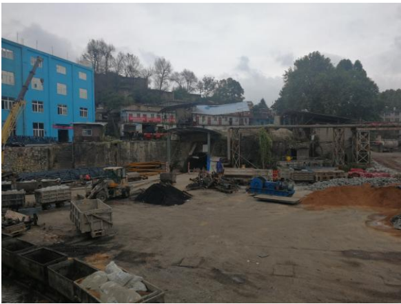
利用新建工业场地进行施工
