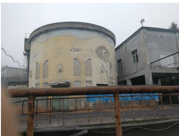
原有矿井水净化塔
