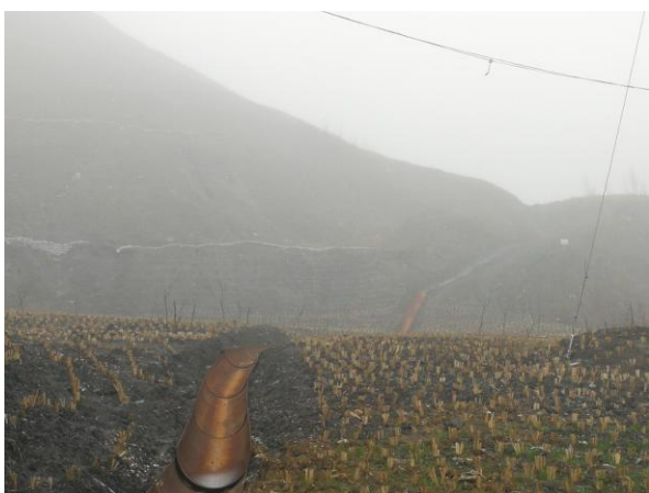
矸石场沟渠及绿化
