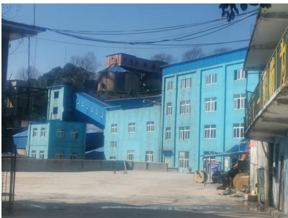
工业场地地面硬化
