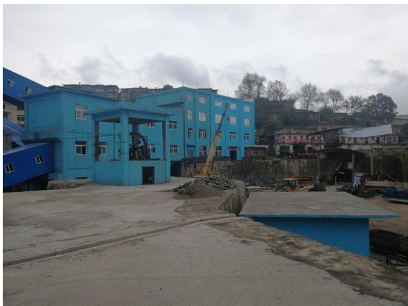
工业广场地面硬化
