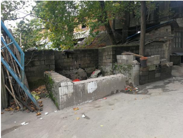
施工期生活垃圾池
