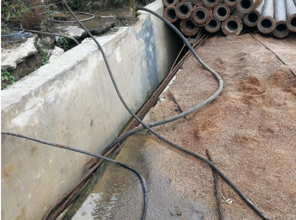
工业场施工地水沟
