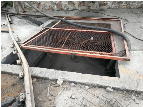
工业场地沉淀池
