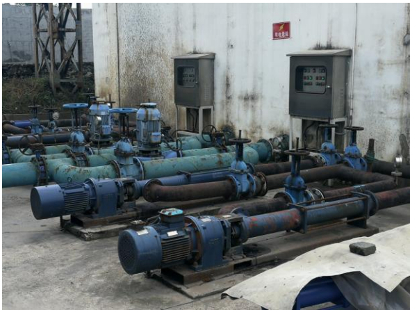
水泵隔声减振机座及软性连接
