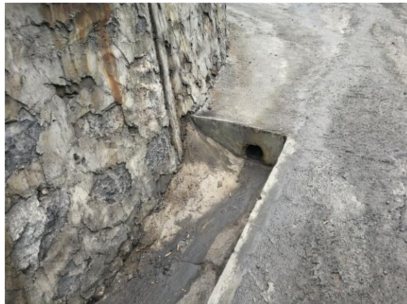
工业广场挡墙及排水沟渠
