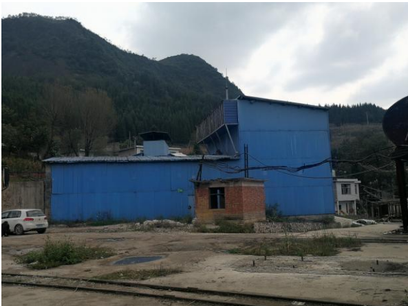
通风机彩钢棚封闭
