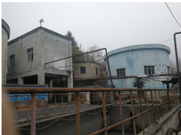
原有矿井水处理站
