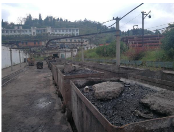
施工建筑垃圾及矸石运输
