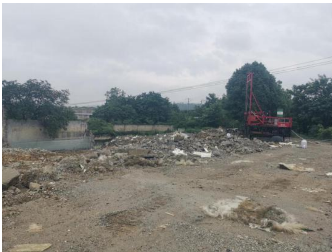
图 2.5-6 已拆除的污水处理设施
