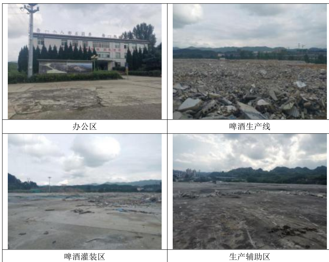
图 2.1-3 生产区域地建筑物拆除情况
