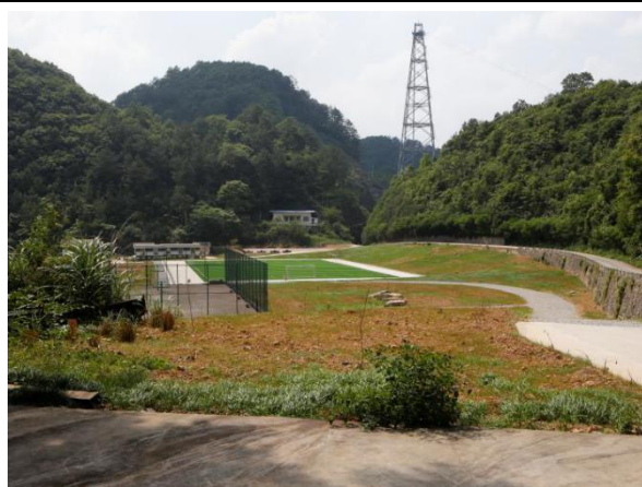
弃渣场植被恢复及综合利用
