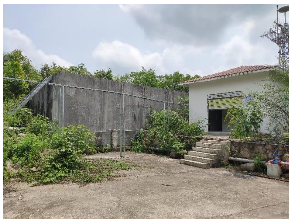
生活用水蓄水池
