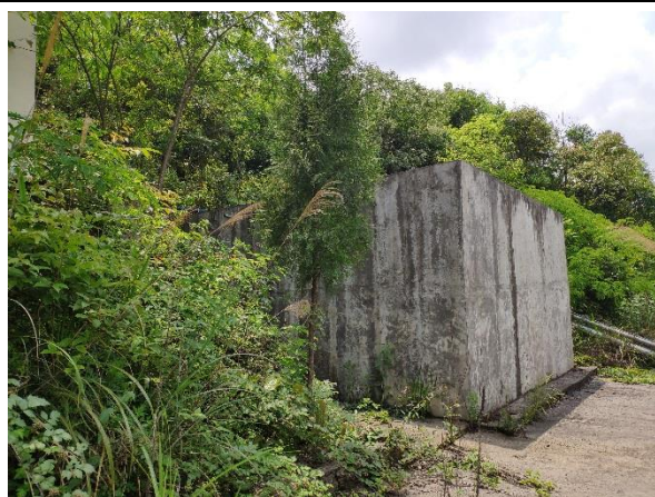
生活用水给水站过滤水池
