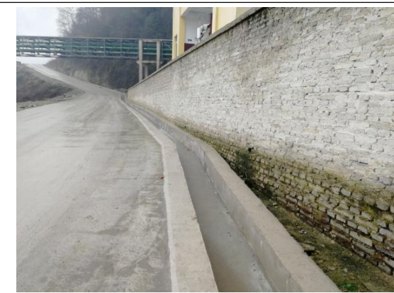
降压站周围排水沟
