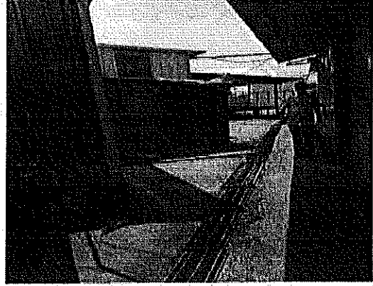
场地废水收集沟
