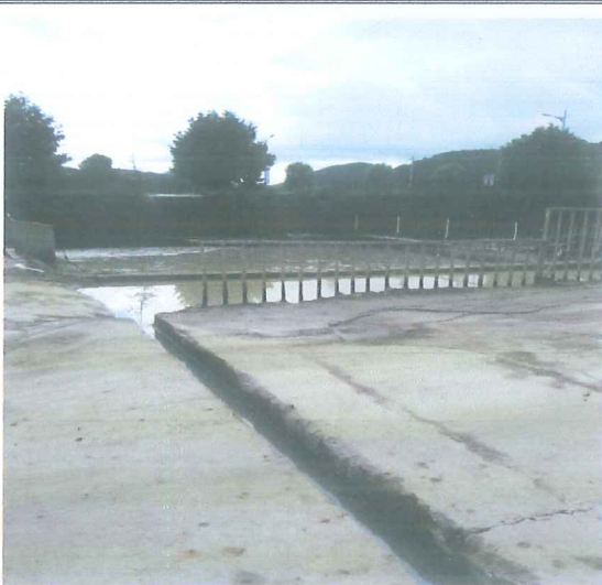
导入沉淀池的污水沟
