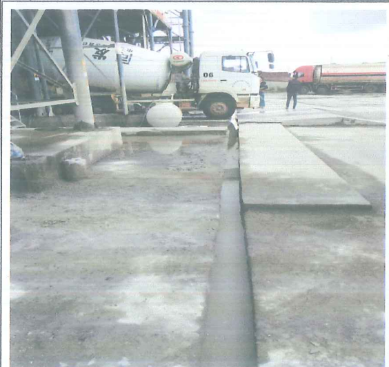
生产场地污水沟
